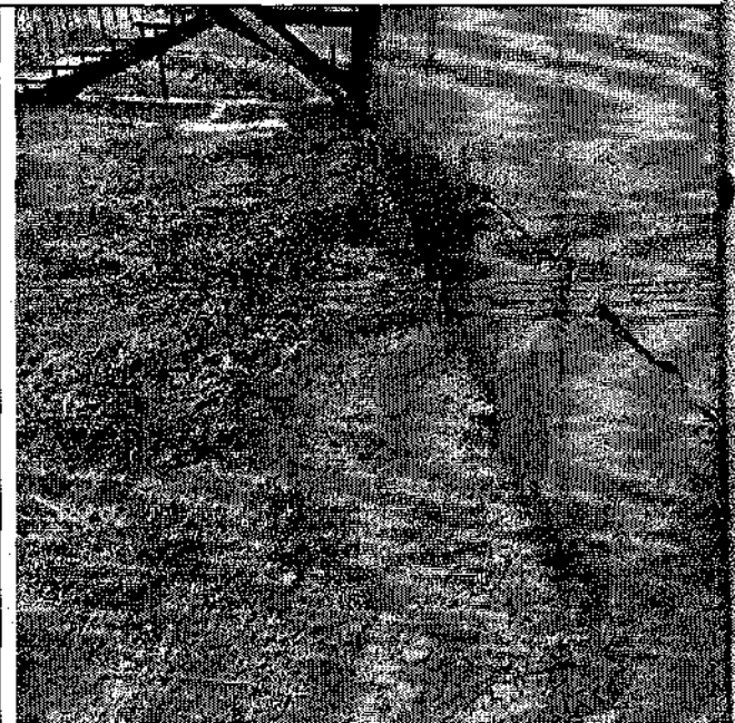
Фото 1-4. Наличие трещин и локальных разрушений окрасочного и штукатурного слоя.
