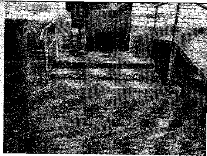
Фото 7-8. Сколы, выбоины и трещины монолитных участков и ступеней входных групп.
